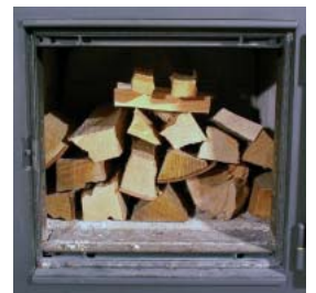
Speicheröfen: Holzscheiter mit Stirnseite nach vorne einlegen
